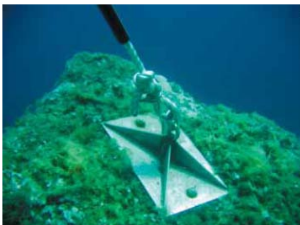
Εικόνα 14. Μεταλλική πλάκα πακτωμένη σε βραχώδες υπόστρωμα (Francour et al., 2007)
