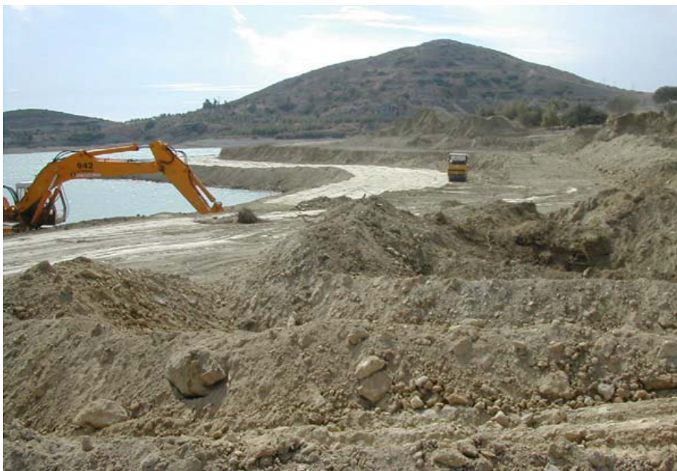
Φωτογραφία 3 Τεχνικές επεμβάσεις για την κατασκευή τεχνητού υγρότοπου στον ταμιευτήρα Μπραμιανών Ιεράπετρας.
